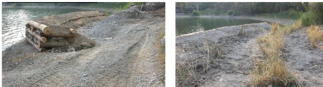
Figura 3: Ripristino spondale lacustre tramite palificata e messa a dimora del canneto – Lago Grande di Avigliana (fonte: Aimone, 2014)
