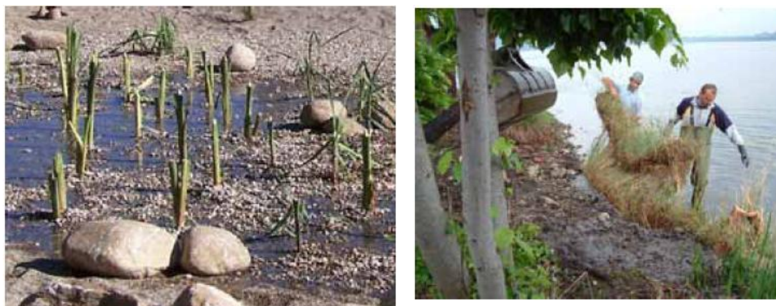
Figura 4: Impianto di canneto tramite zolle (a sinistra) ed impianto di canneto tramite rulli (a destra) (fonte: AA.VV. 2011 – Quaderni della ricerca n. 125 - Regione Lombardia)
